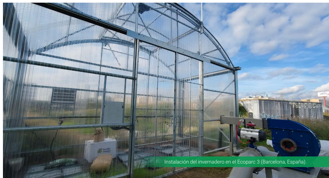
Instalación del concentrador y biofiltro percolador en el Ecoparc 3 (Barcelona, España).
