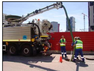
Servicio de Limpieza Alcantarillado
