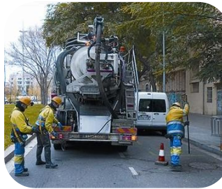
Limpieza de alcantarillado
