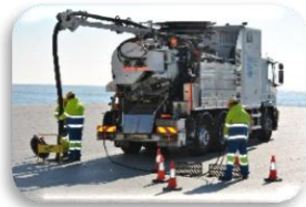
Servicio de limpieza y mantenimiento de alcantarillado
