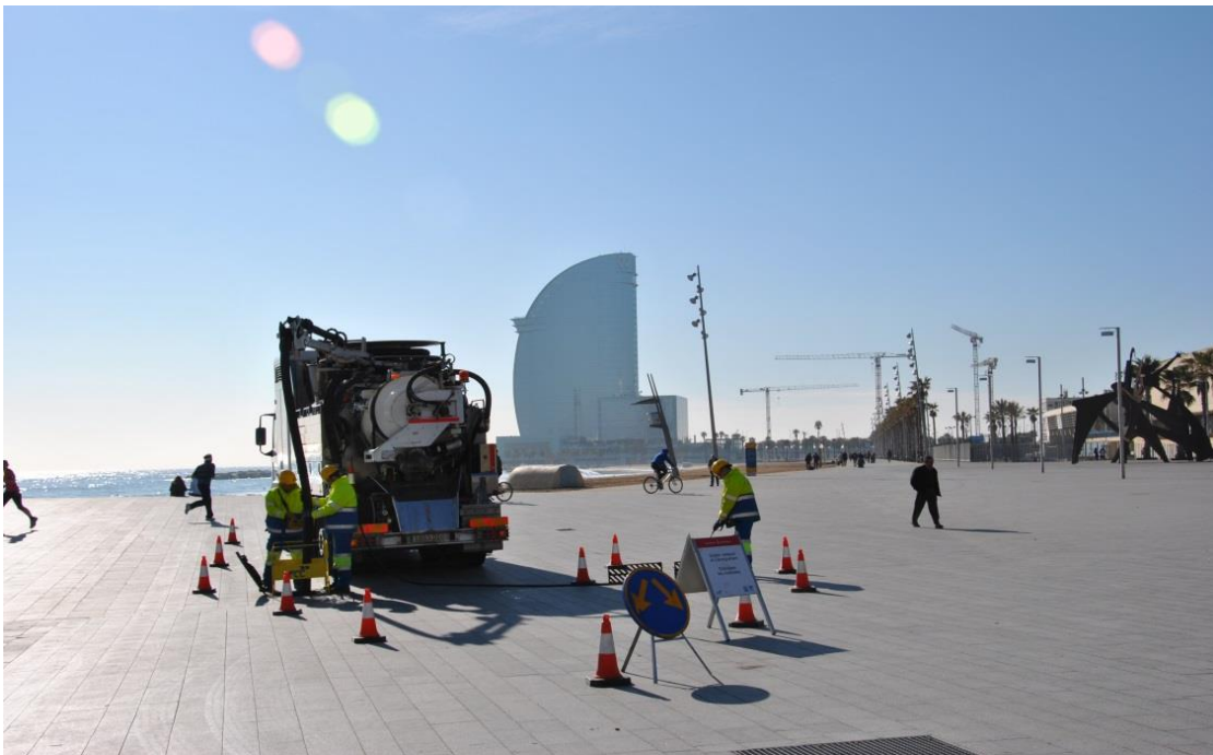
Proceso de limpieza de alcantarilla en litoral
