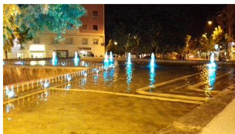
Fuente Virrei Amat - iluminación LED
