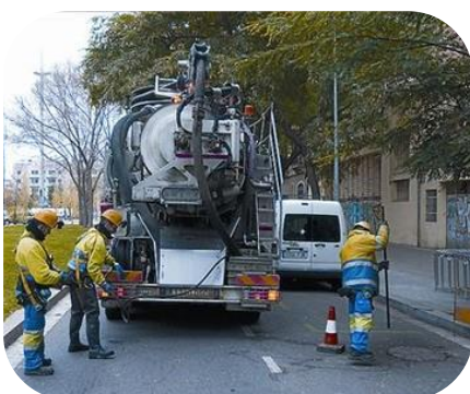
Limpieza de alcantarillado
