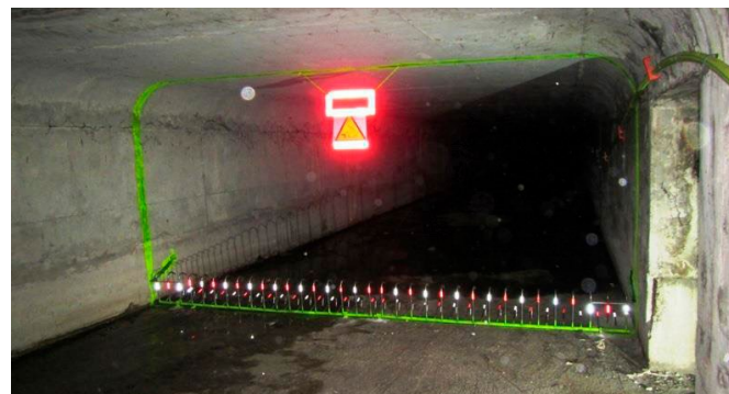
Peines de retención alcantarillado Barcelona.
