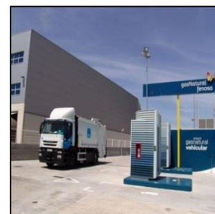
Instal·lacions de Gas Automoció
