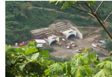
Túnel Xicotepéc México
