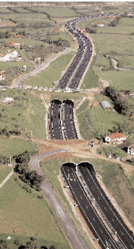
Autovía Minera. Asturias
