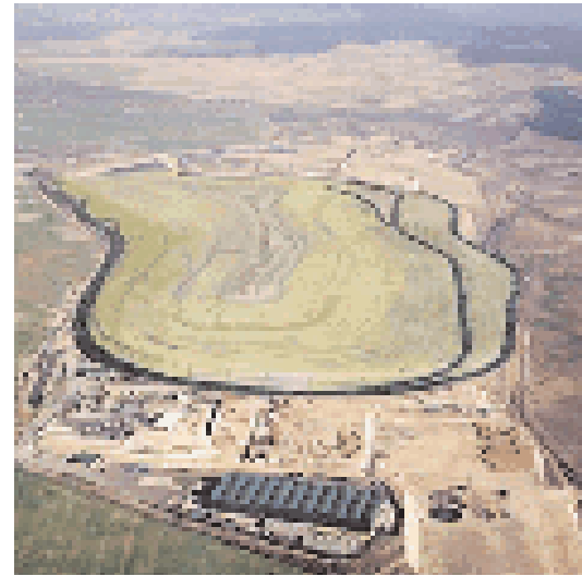
Cap on the landfill in Pinto. Madrid
