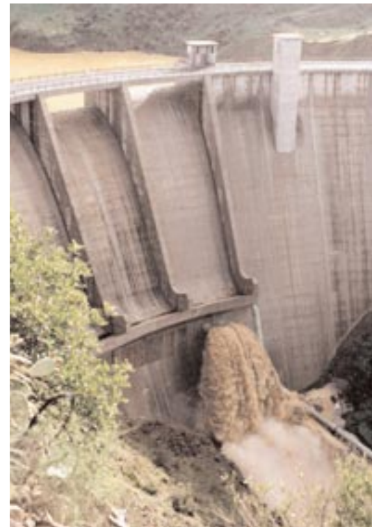
Casasola Dam. Campanillas River. Almogía. Málaga
