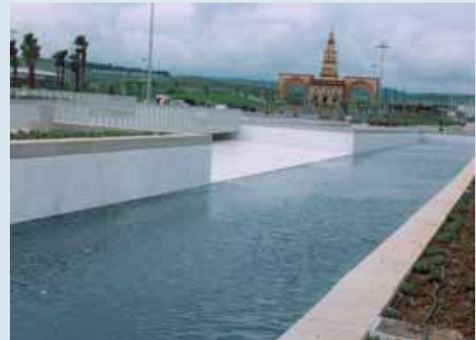
Urbanisation El Balcón in Guadalquivir. Córdoba
