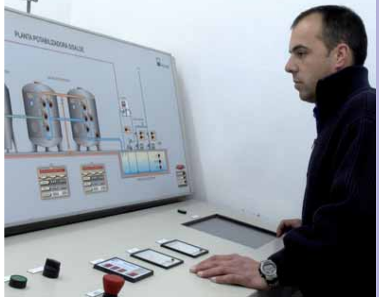
Centro de control de planta potabilizadora de agua de mar
