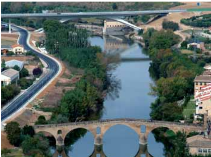
Autovía del Camino dual carriageway. Navarra
