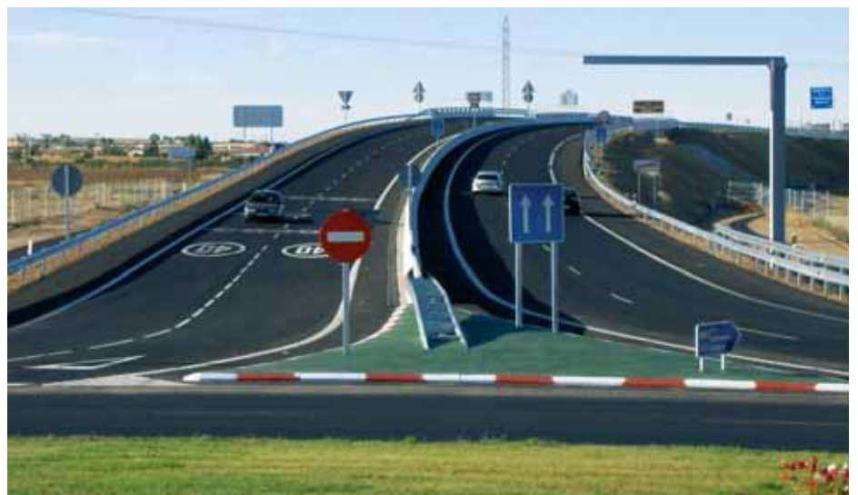
Autovía del Duero dual carriageway Toro-Zamora section
