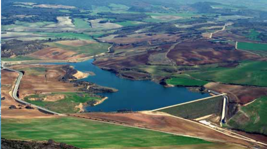
Treviño Dam. Burgos
