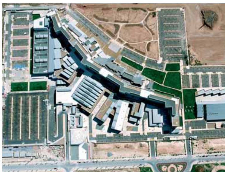
Wastewater treatment plant in Cabezon de la Sal. Cantabria Aerial view of Hospital General de Ciudad Real
