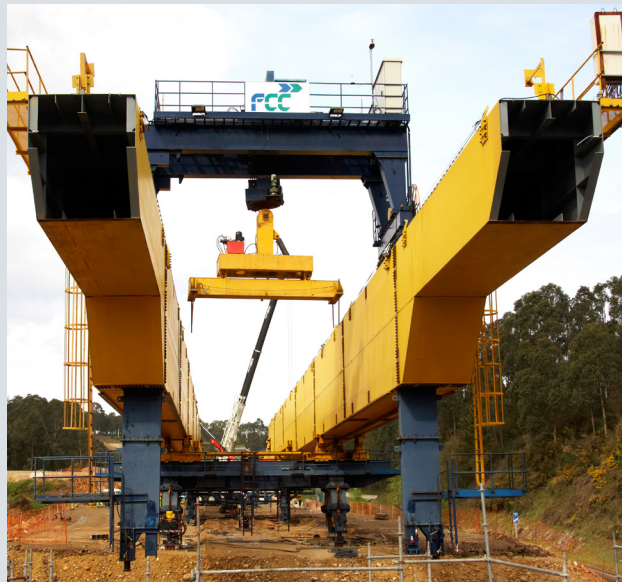
Lanzador de dovelas
