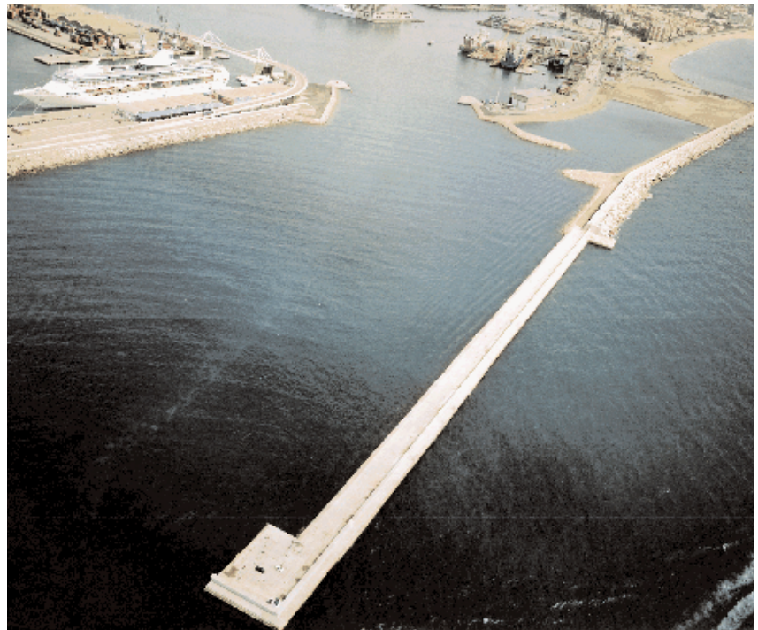
Nueva bocana del puerto de Barcelona
