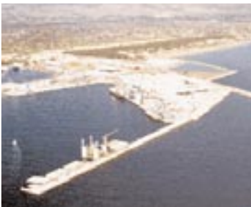
Remodelación del puerto de Castellón
