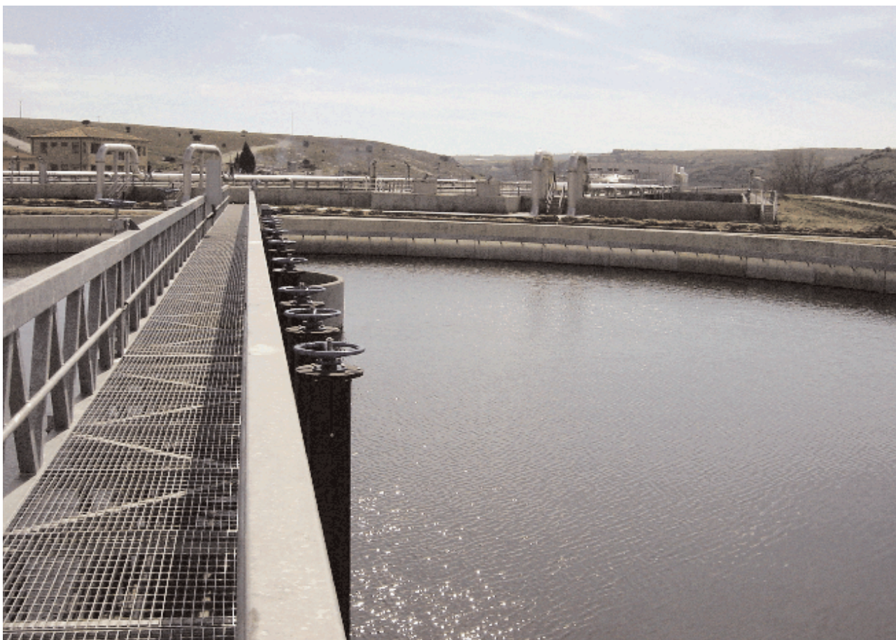
Depuradora de aguas residuales. Salamanca
