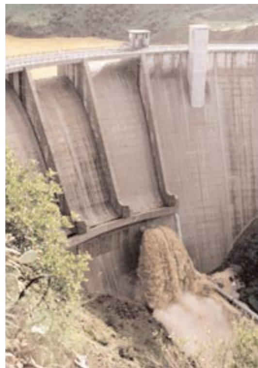
Presa de Casasola. Río Campanillas. Almogía. Málaga
