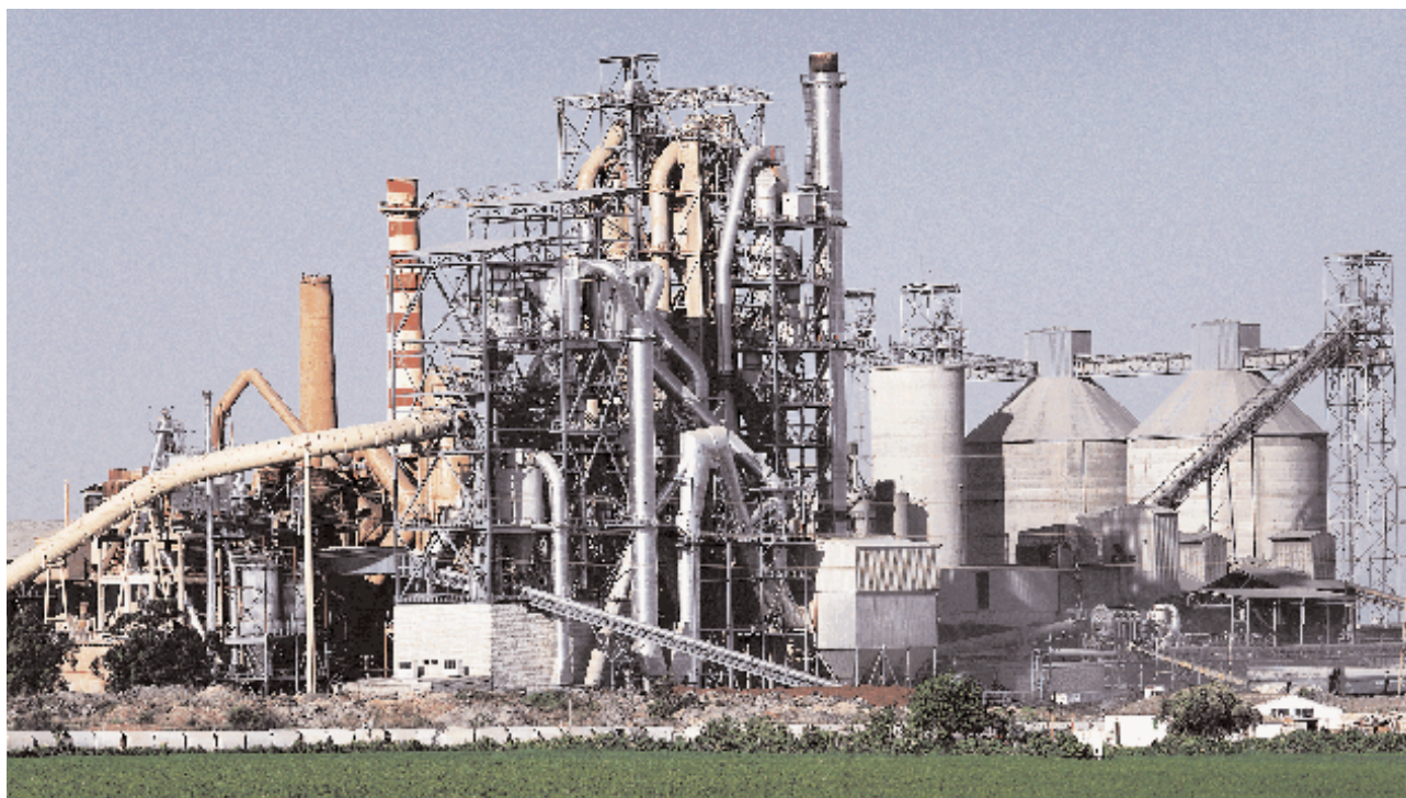
Fábrica de cementos de Alcalá de Guadaira. Sevilla
