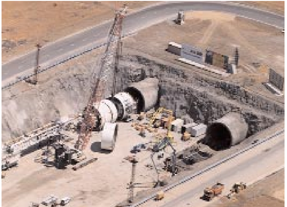
■ Túneles de Guadarrama. Madrid
