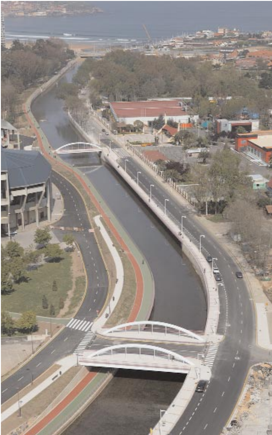
■ Acondicionamiento del río Piles. Gijón
