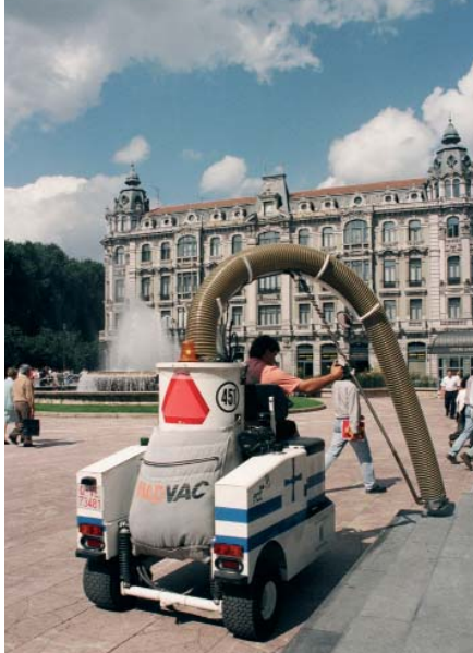
Mantenimiento de alcantarillado. Oviedo
