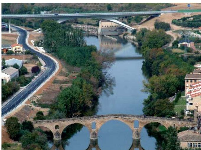
Autovía del Camino. Navarra
