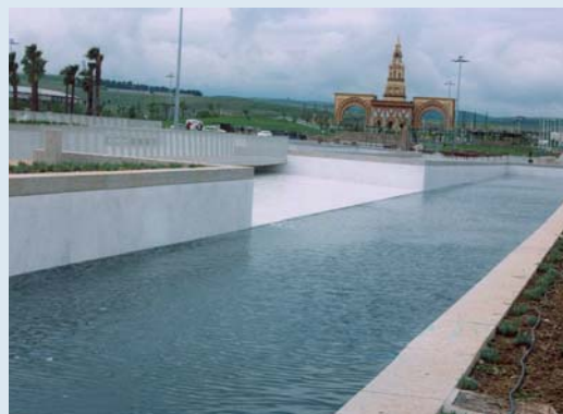
Urbanización El Balcón del Guadalquivir. Córdoba
