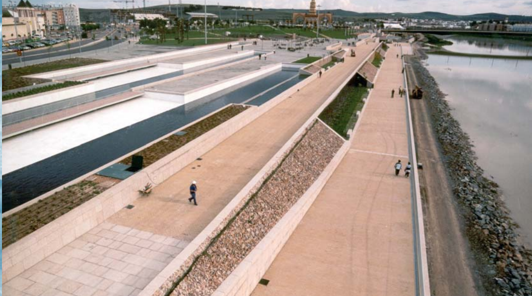
Urbanización El Balcón del Guadalquivir. Córdoba
