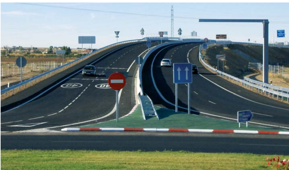
Autovía del Duero. Tramo Toro-Zamora
