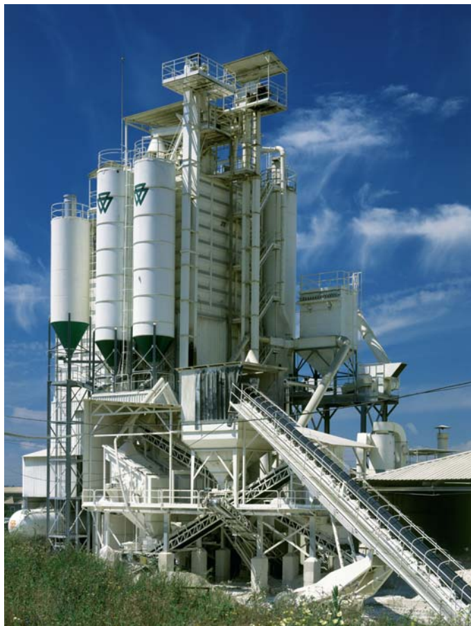
Fábrica de cemento en Alcalá de Guadaira. Sevilla
