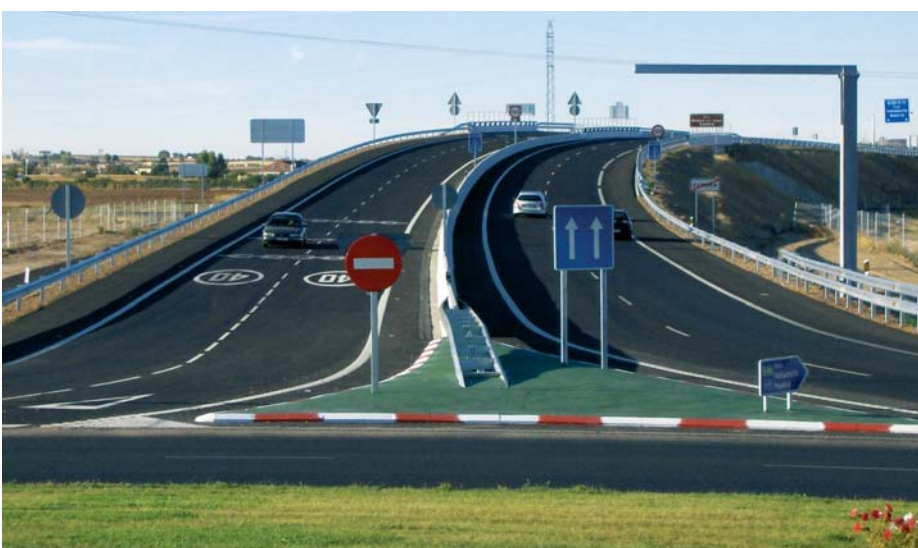
Autovía del Duero. Tramo Toro-Zamora
