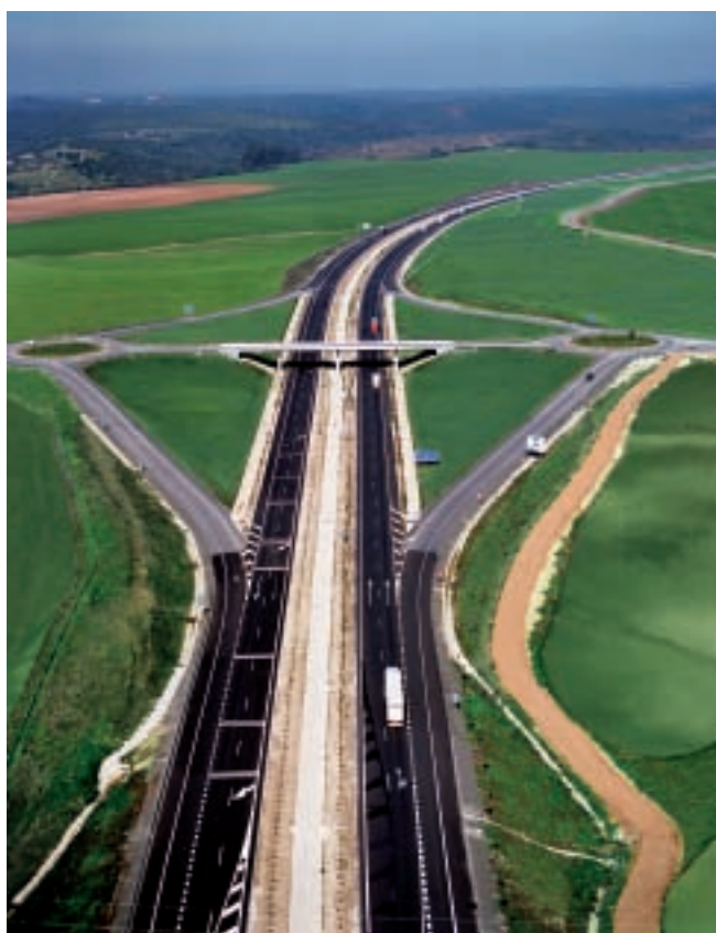
Autovía de La Plata. Tramo Gerena-Camas. Sevilla
