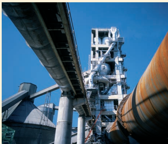
Fábrica de Cementos Lemona. Vizcaya
