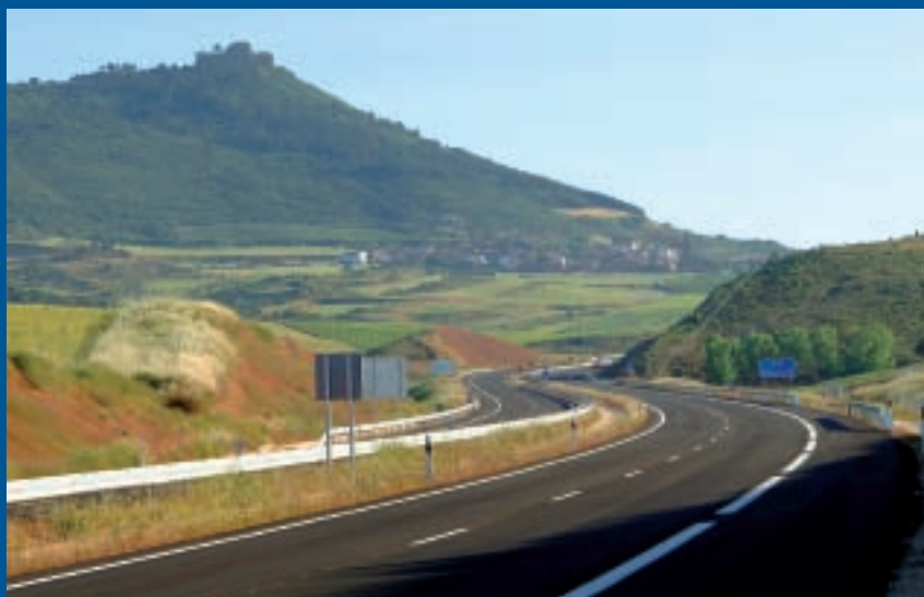
Autovía del Camino. Tramo Pamplona-Logroño
