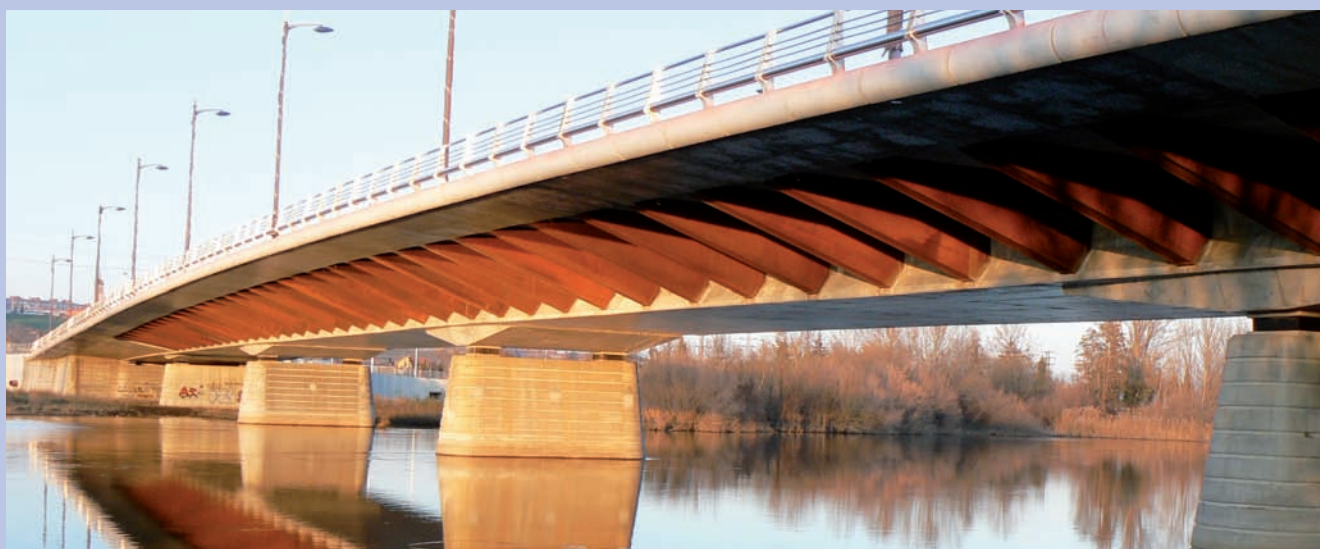
Puente de la Serna. Salamanca
