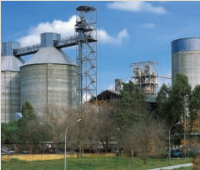
Fábrica de Alcalá de Guadaira. Sevilla
