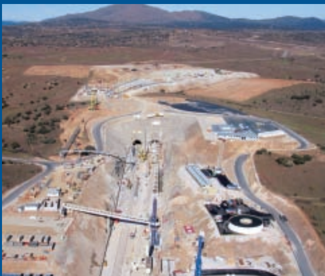
Túneles de San Pedro. Madrid
