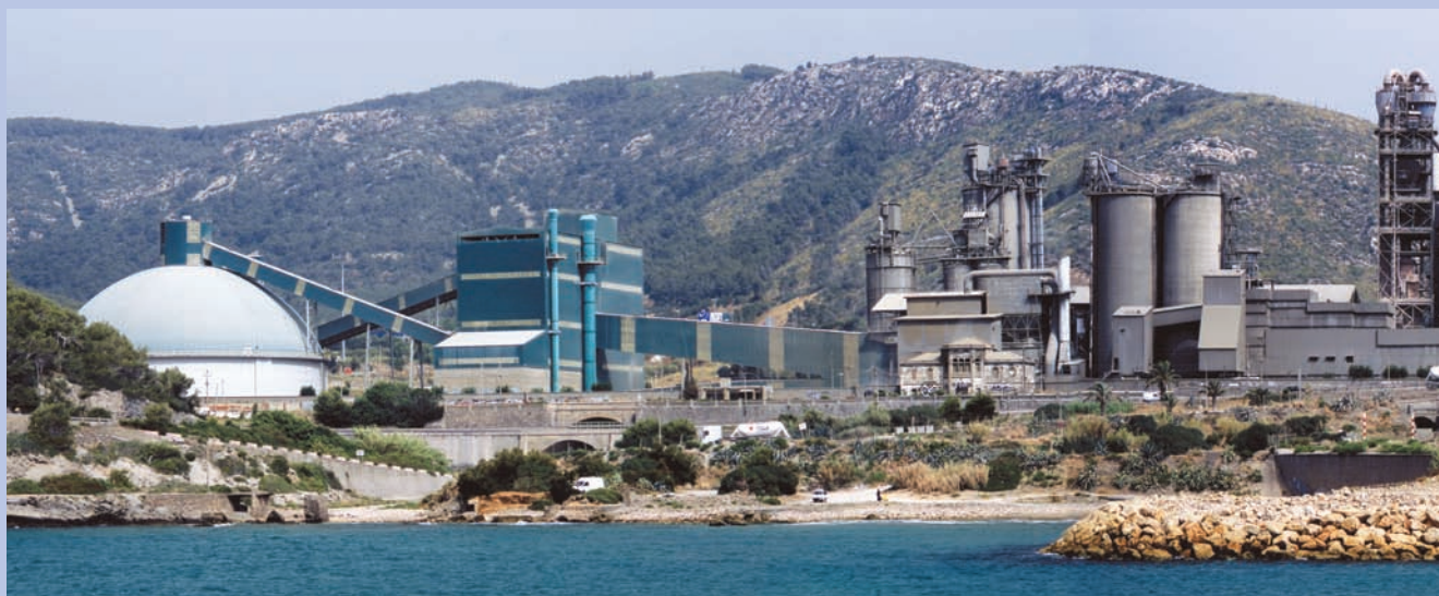
Fábrica de cemento. Vallcarca. Barcelona
