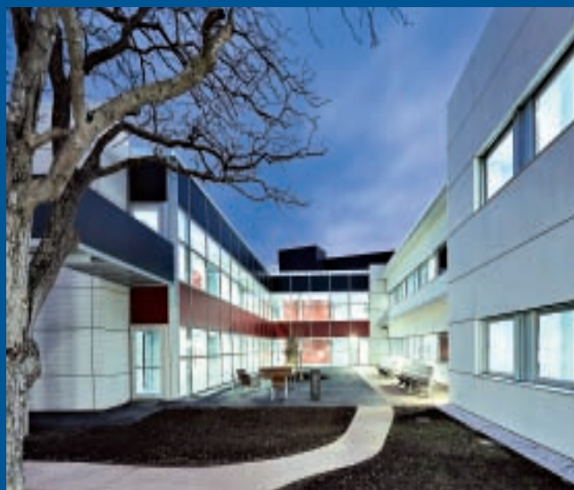
Centro de disminuidos psíquicos San José. Pamplona
