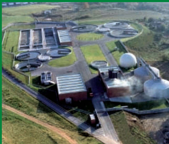
Depuradora de Sabadell (SPA). Barcelona
