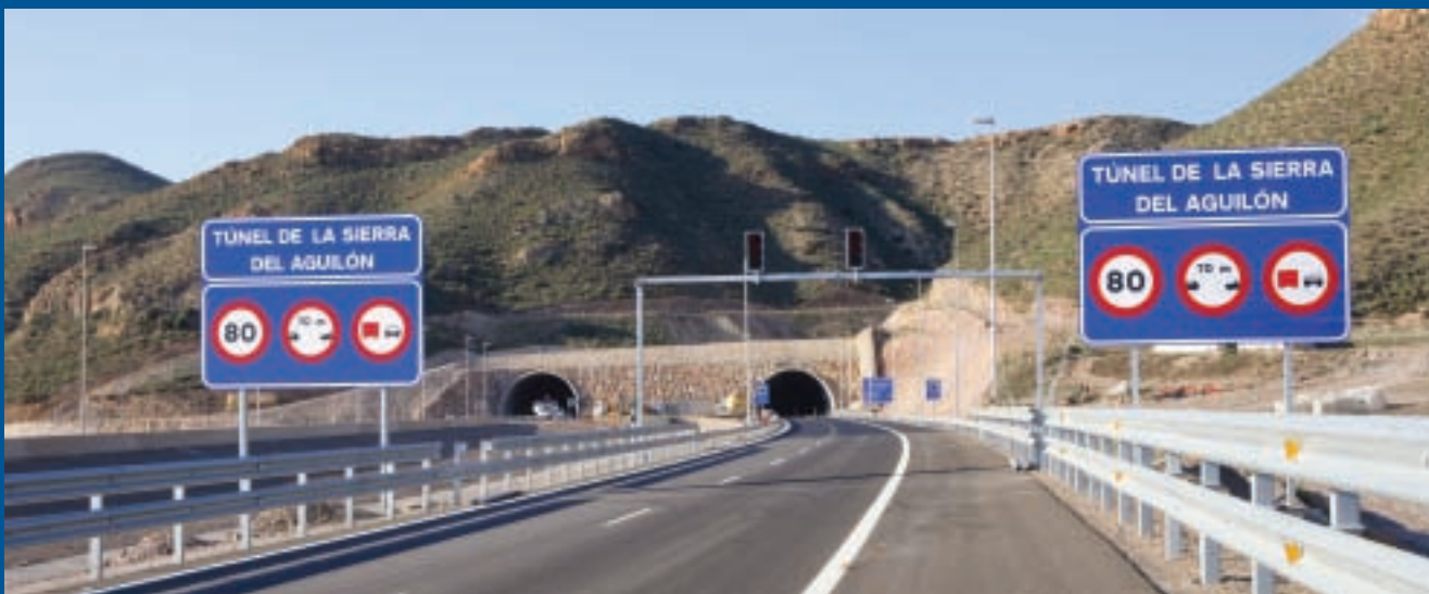
Autopista AP7. Tramo Cartagena-Vera
