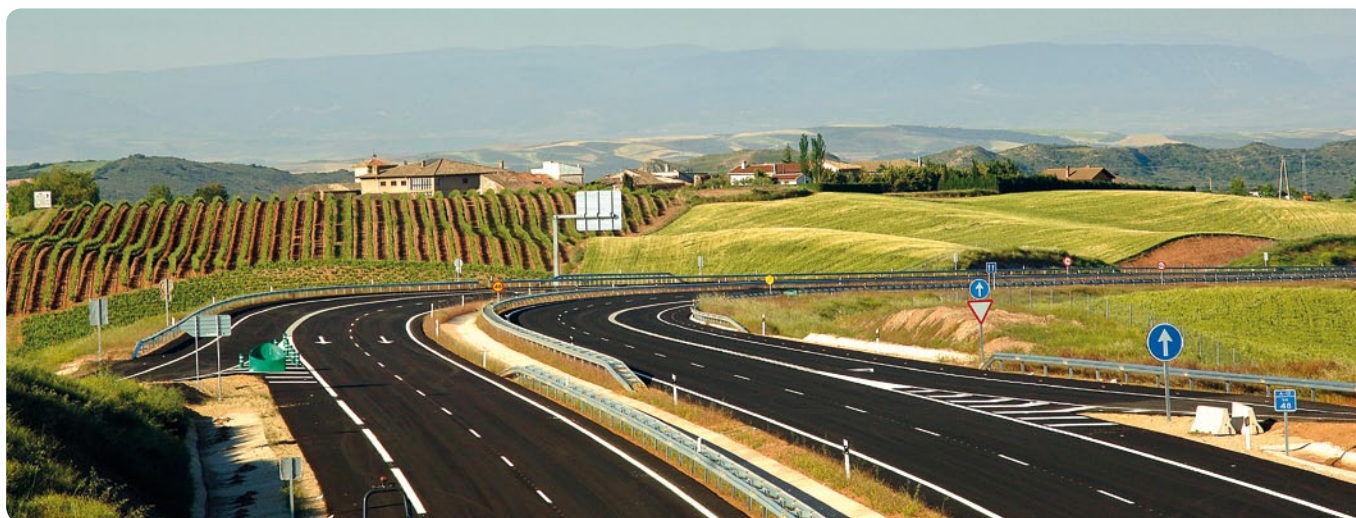
AUTOVÍA DEL CAMINO, NAVARRA.
