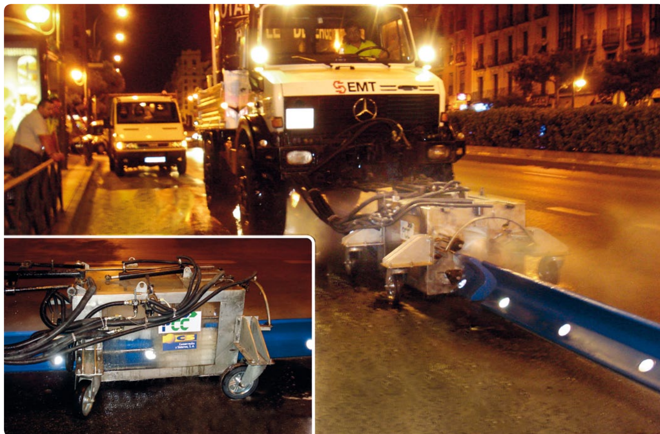
LIMPIEZA DE SEPARADORES CARRIL-BUS, MADRID.
