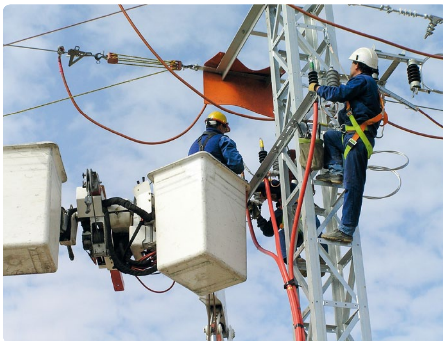
TRABAJOS EN ALTA TENSIÓN
