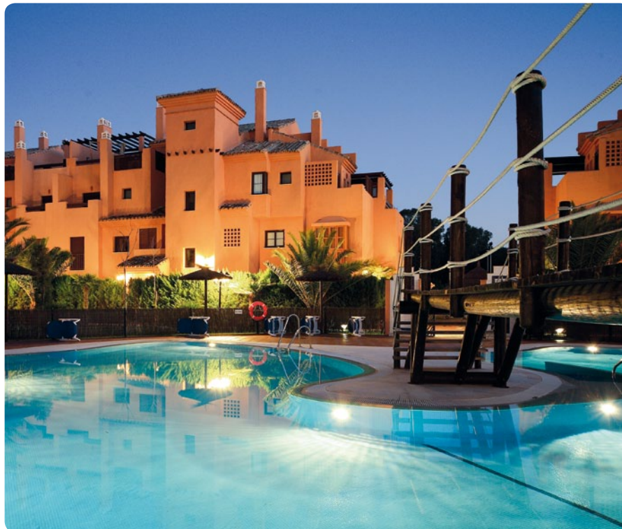
RESIDENCIAL HACIENDA DEL SOL, MÁLAGA.
