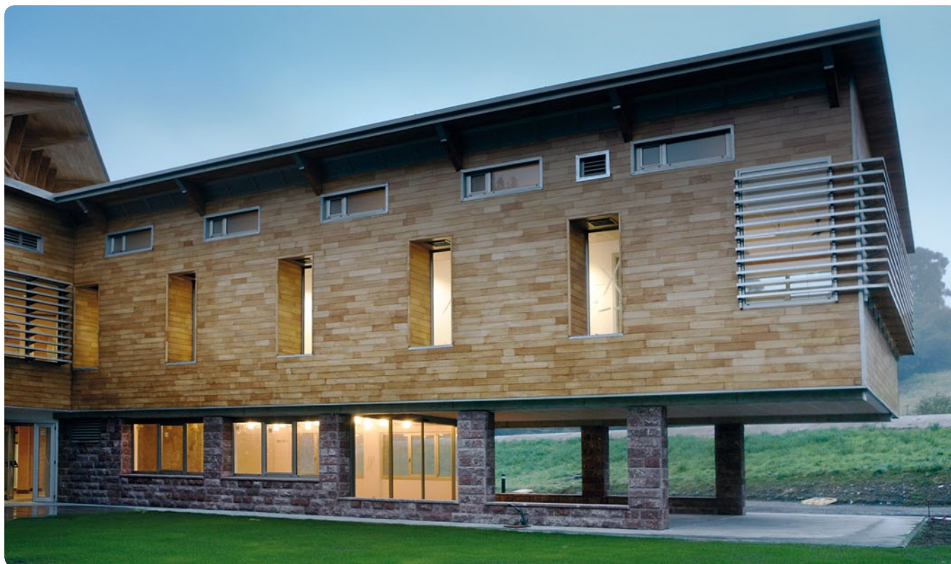
PROYECTO ARFRISOL, OFICINAS BIOCLIMÁTICAS CON FRÍO SOLAR.
