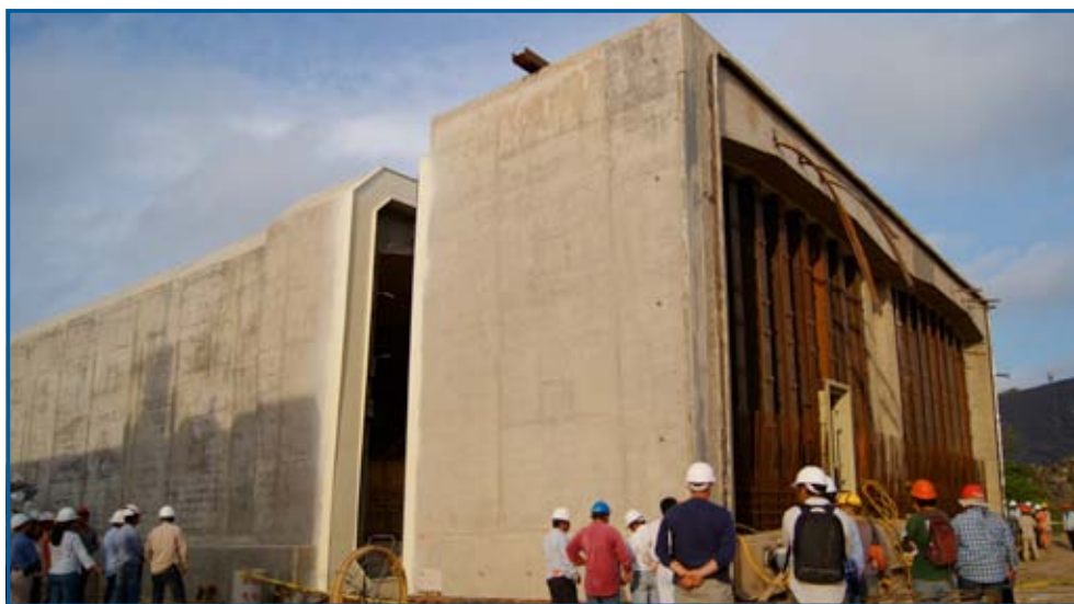
Túnel de Coatzacoalcos (México)
