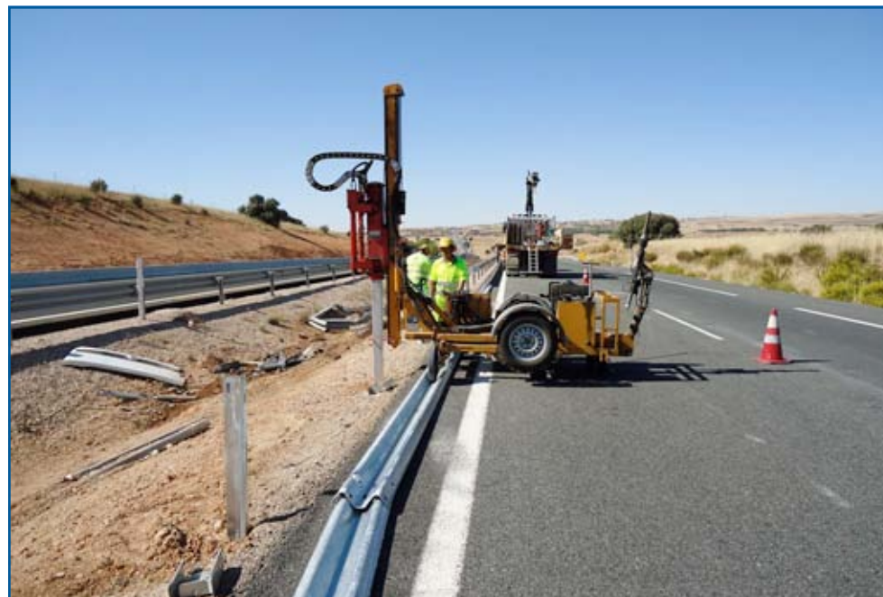
Colocación de vallas protectoras en autopistas
