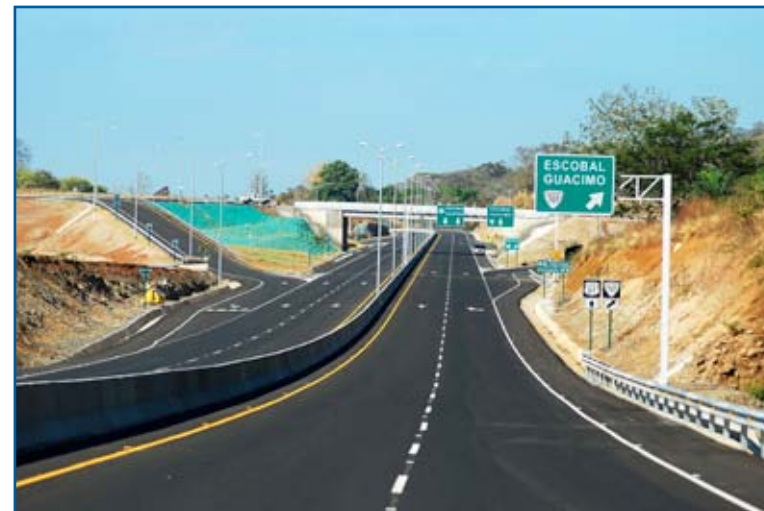
Autopista San José Caldera, Costa Rica
