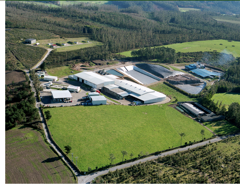
Centro de tratamiento de residuos sólidos, Barbanza, La Coruña.
