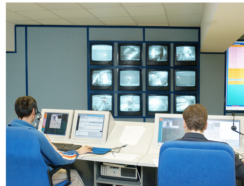
Centro control de galerías de servicio, Madrid.
