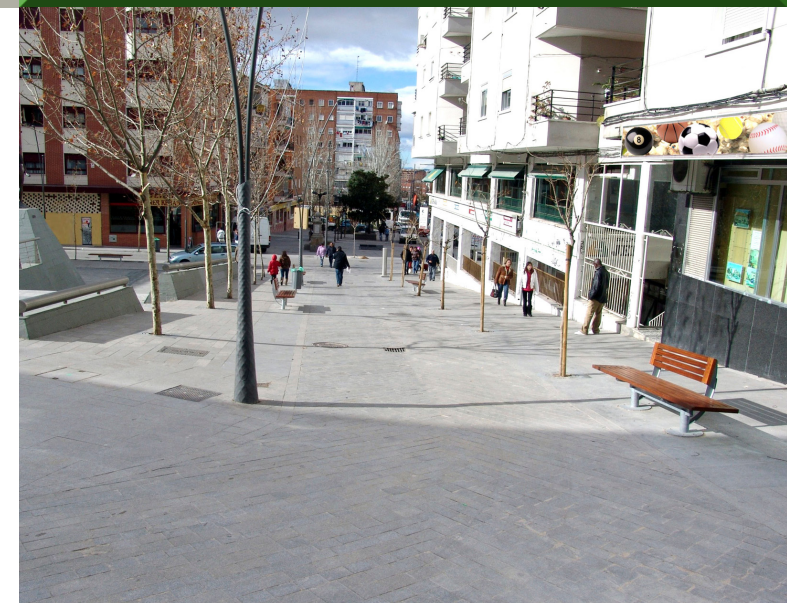
Remodelación de la zona centro Alcorcón, Madrid.
